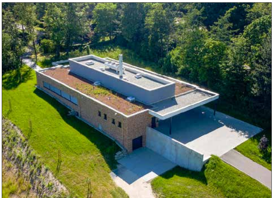
Im Dezember 2020 nahm das neue Göppinger Krematorium den Betrieb auf.
